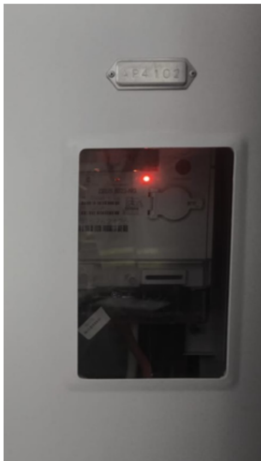
Figura 1: (a) Quadro de medição composto por seis medidores inteligentes com a caixa metálica aberta. (b) Caixa metálica fechada com a abertura fechada de vidro para a visualização do display. A tabela a seguir apresenta a disposição física dos medidores por andar, separados por torre, e o total geral:
