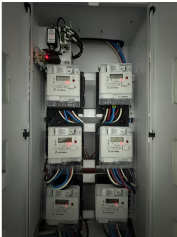
Figura 1: (a) Quadro de medição composto por seis medidores inteligentes com a caixa metálica aberta. (b) Caixa metálica fechada com a abertura fechada de vidro para a visualização do display. A tabela a seguir apresenta a disposição física dos medidores por andar, separados por torre, e o total geral:
